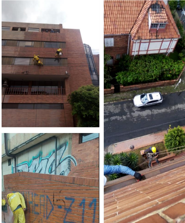
Fuente: Archivo fotográfico recurso físico, Lavado de fachadas, Clínica Nueva, 2022
