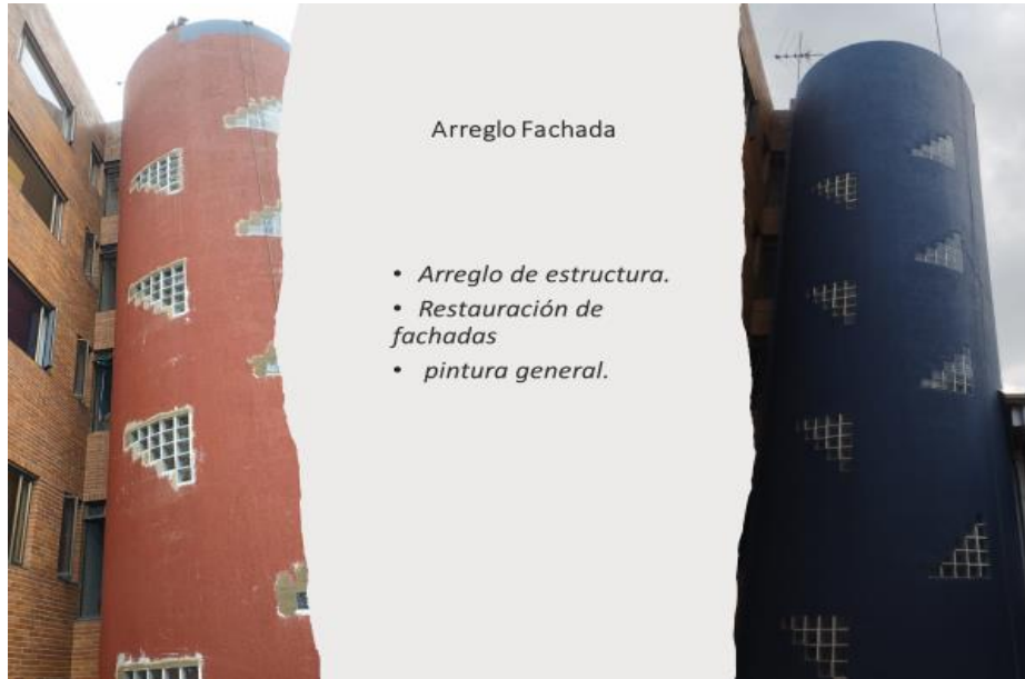
Fuente: Archivo, restauración de fachadas, Antes, Después, Clínica Nueva, 2022
