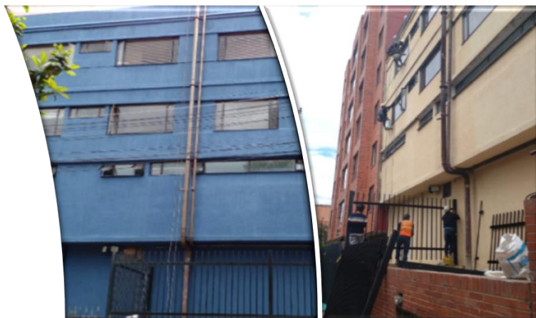
Fuente: Archivo fotográfico recurso físico, restauración de fachadas, cerramientos, Clínica Nueva, 2022
